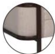
DETALLE ESTRUCTURA METALICA
